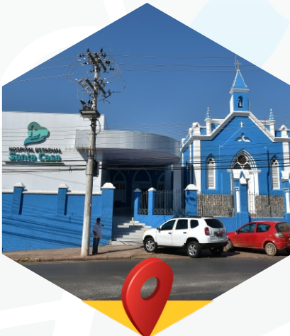
Reforma da Santa Casa de Misericórdia de Cuiabá
