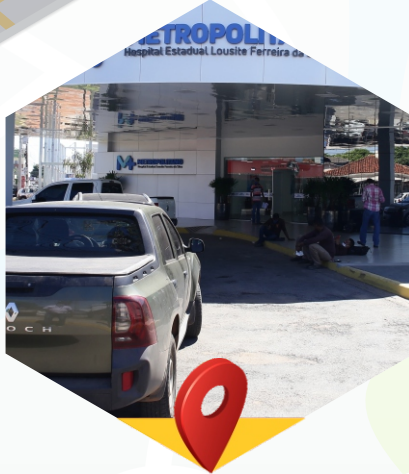
Ampliação do Hospital Metropolitano de Várzea Grande
